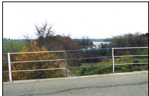
Abb. 7: Eisenbahnbrücke mit Blick auf „nach Hause“, Richtung Marsow
