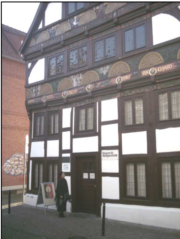
Abb. 2: Eines der wieder hergerichtete schönen alten Fachwerkhäuser beherbergt nun das Stadtgeschichtsmuseum von Paderborn
