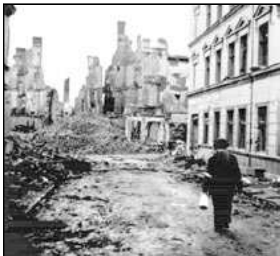
Abb. 4: Zerstörter Strassenzug in Küstrin
